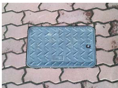
Pojezdový poklop – nosnost 12,5 t
